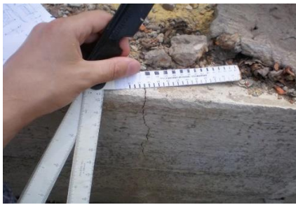
а) монолитті темірбетонды іргетастағы жарықшақ; б) тірек арматурасының коррозиясы
