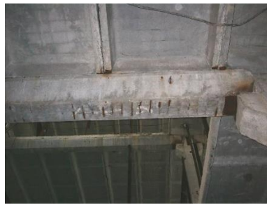
а) монолитті темірбетонды іргетастағы жарықшақ; б) тірек арматурасының коррозиясы
