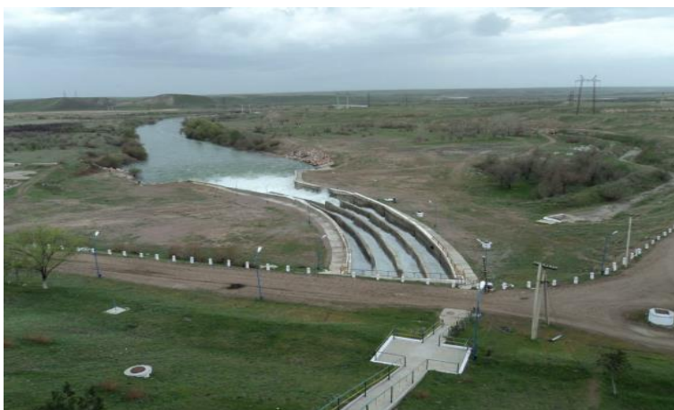
Сурет 2. Тасөткел бөгетінің су тастау құрылымы
