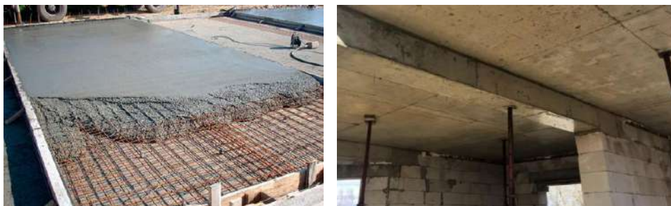
Сурет 3. Монолитті бетон қосылған құрама бетон төбесі
