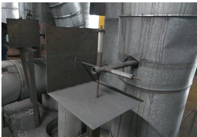
Рис. 1. Указатели тепловых перемещений «РЕПЕРЫ»
